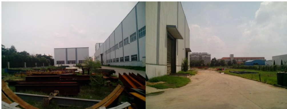
探伤房拟建场址东侧
