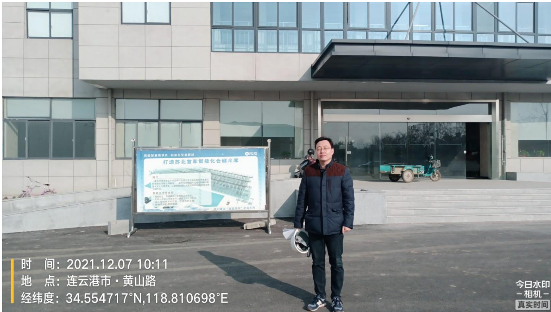
附图 7 工程师现场勘查照片
