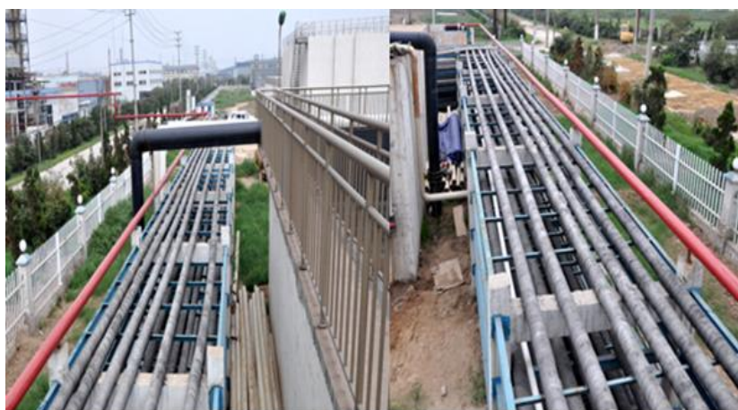
图 3-1 园区污水处理厂“一企一管”管廊图
