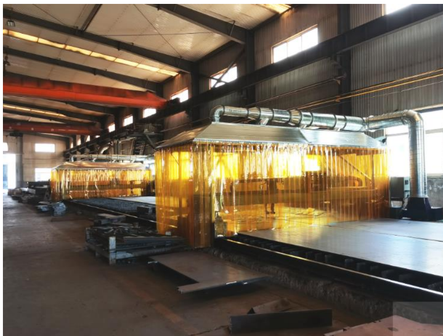
图 6.1-4 集气罩及软帘安装效果图
