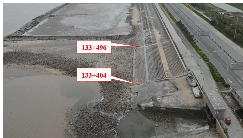
图 30 桩号 133+404~133+496 段现状护坡图
