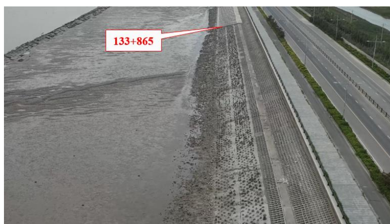
图 33 桩号 133+496~133+865 段现状护坡图
