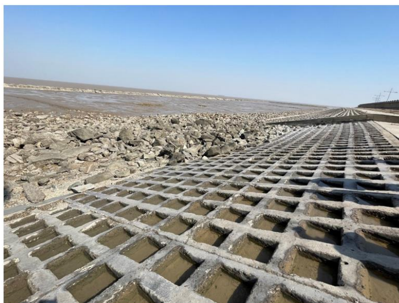
图 23 桩号 135+657~135+697 段现状槽型块护坡图片
