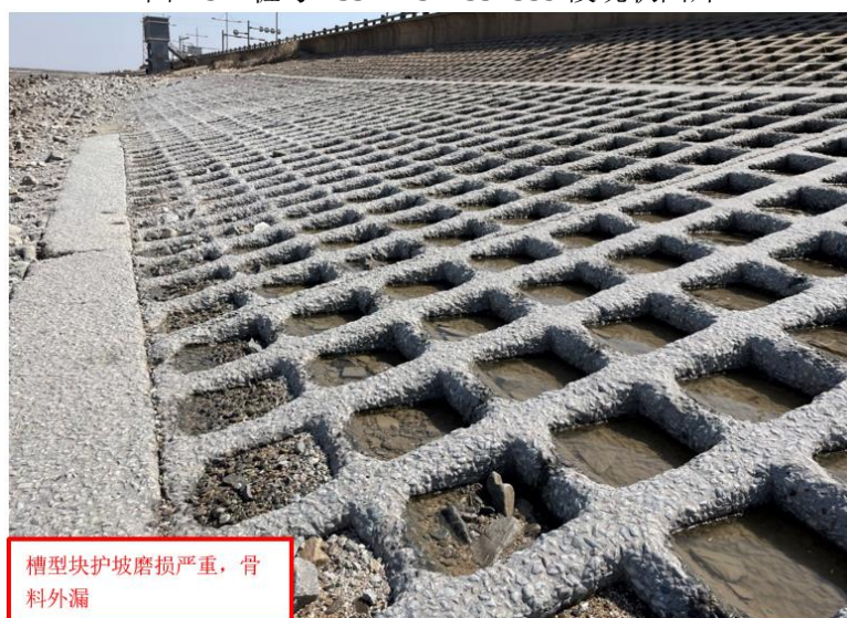
图 20 桩号 135+445~135+559 段现状槽型块护坡图片
