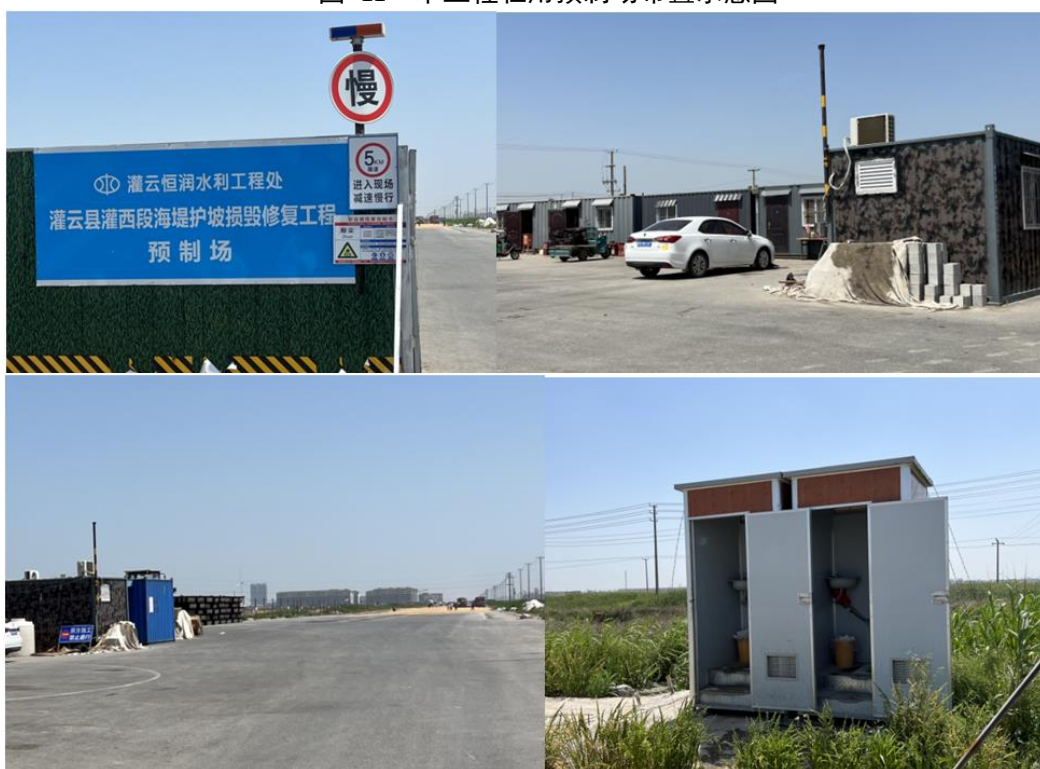
图 12 本工程租用预制场现状
