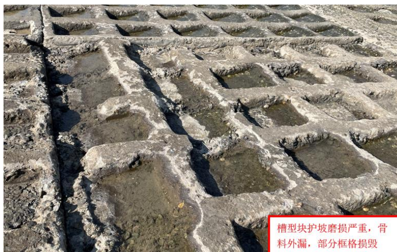
图 26 桩号 136+655~136+960 段现状槽型块护坡图片
