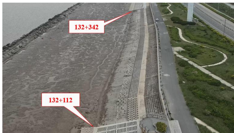
图 27 桩号 132+112~132+342 段现状护坡图片
