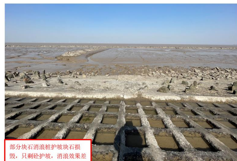
图 36 桩号 135+880~136+410 段现状块石消浪桩护坡图片
