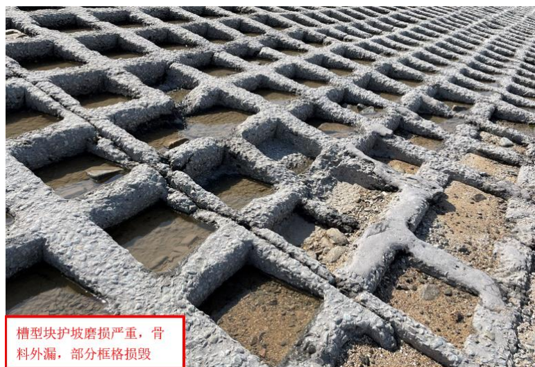
图 21 桩号 135+445~135+559 段现状槽型块护坡图片
