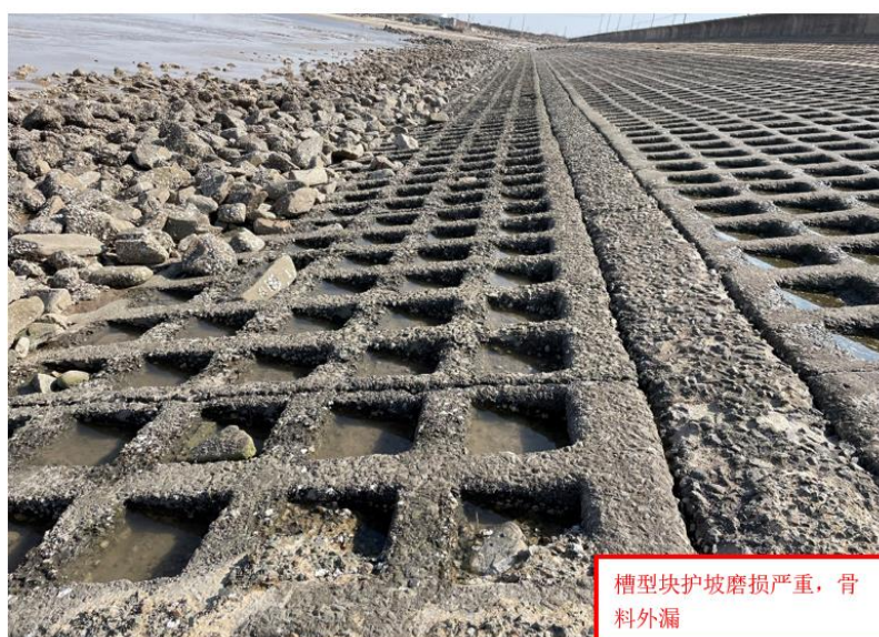
图 25 桩号 136+655~136+960 段现状槽型块护坡图片
