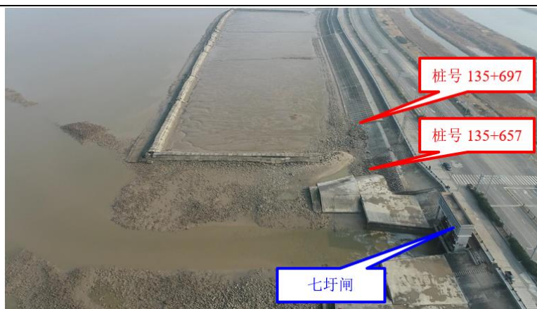
图 22 桩号 135+657~135+697 段现状图片
