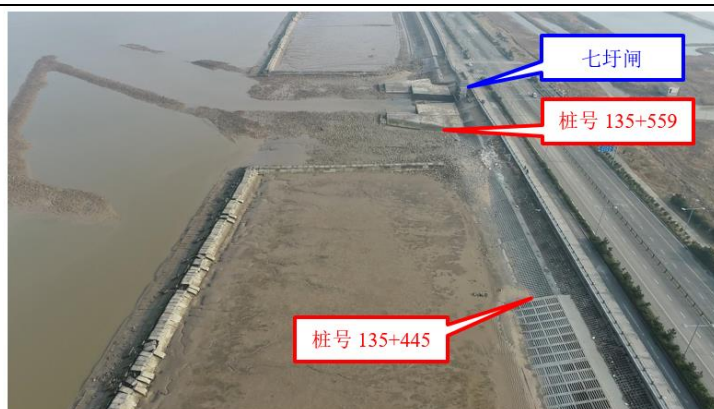
图 19 桩号 135+445~135+559 段现状图片
