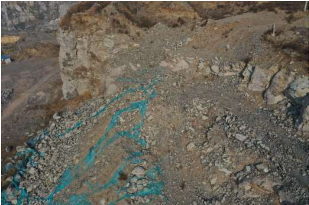
图 3-22 项目区矿坑挖损区松散堆积体和高陡边坡
