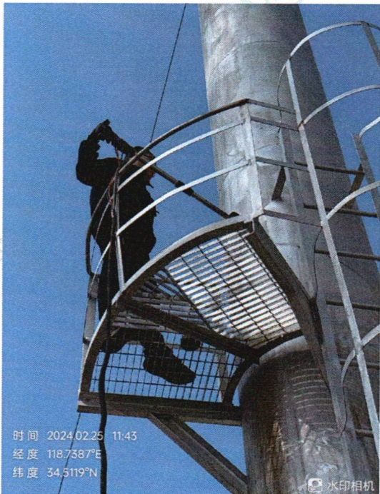
附图 2：锅炉烟气排放口采样现场
