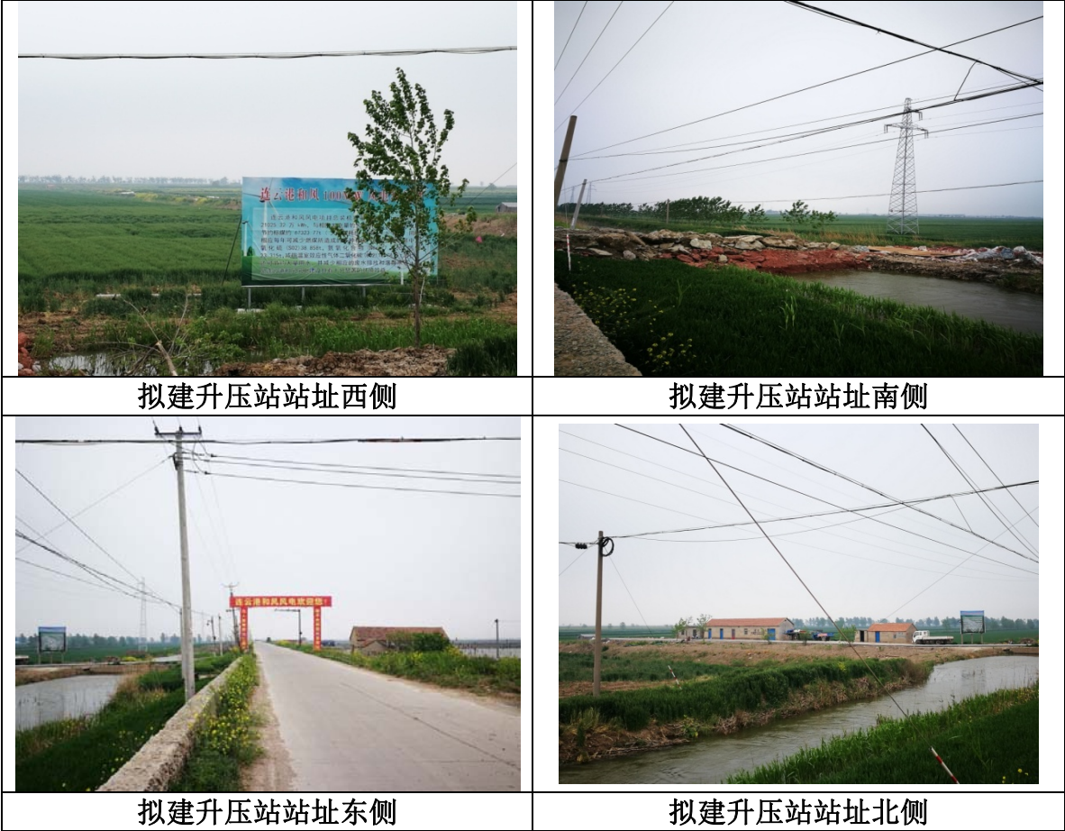
图 1 和风灌西 110kV 升压站现状照片
