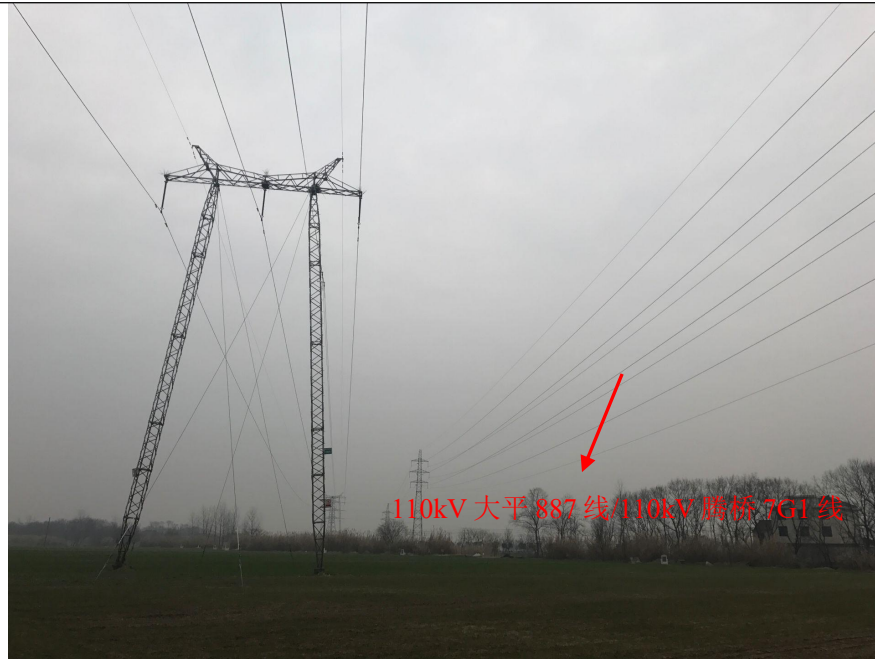
图9-1 类比线路监测断面处照片
