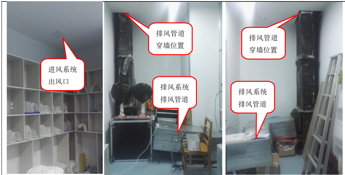
图 10-4 加速器机房通风现状图
