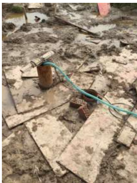
照片 3.2-1 野外抽水试验现场
