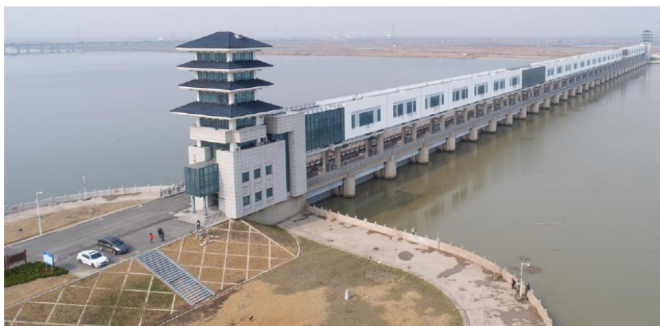
图 1-12 三洋港挡潮闸现状图
