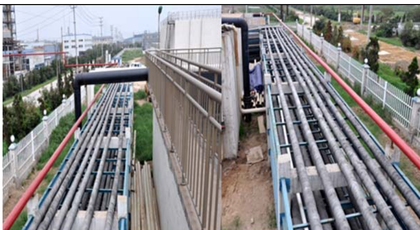
图 3-1 园区污水处理厂“一企一管”管廊图
