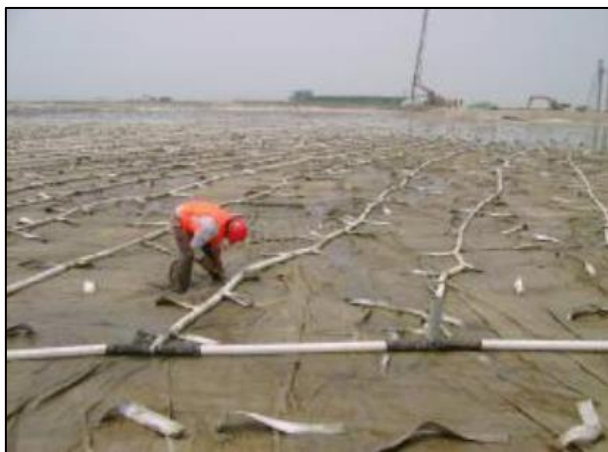
图 2.3-3 铺设水平排水管网图
