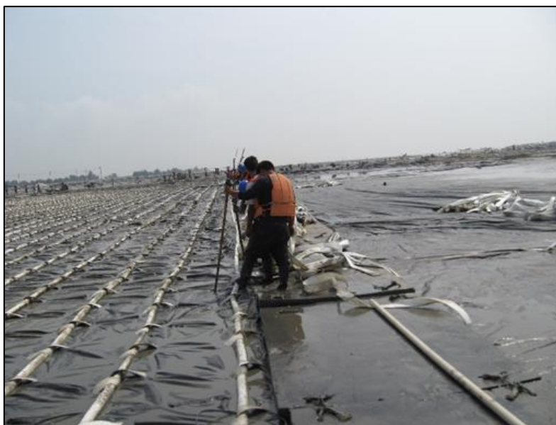
图 2.3-2 人工插打排水板
